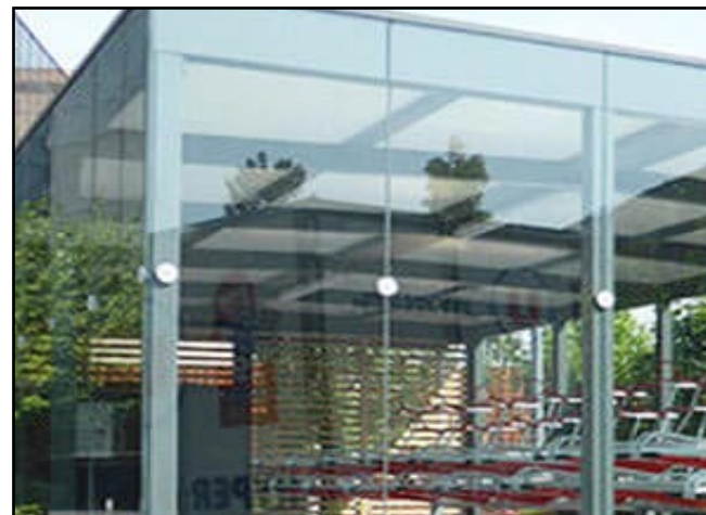
vetro temprato, stratificato gehärtetes und laminiertes Glass
